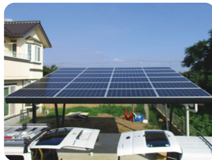
▲ 日本 カーポート10KWプロジェクト
