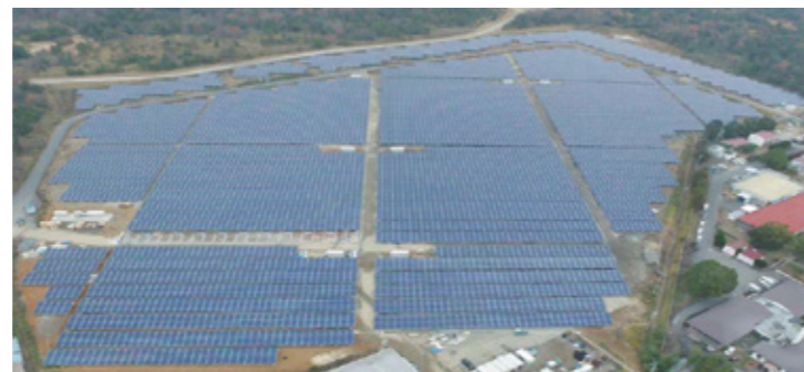
▲ 日本兵庫県10MW太陽光発電所
