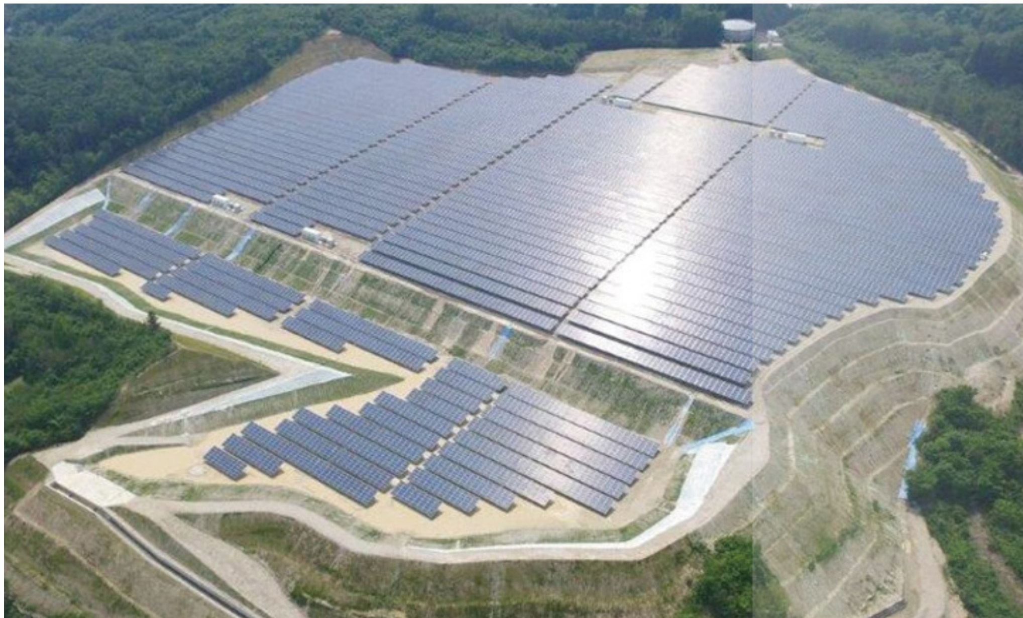
▲ 福島大鷹発電所10 MW
