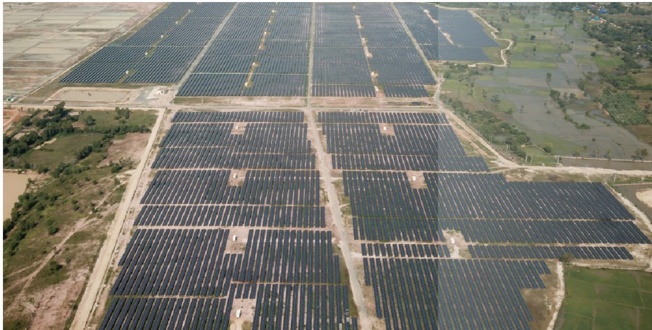
▲ 金辺100 MW太陽光発電所
